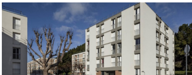
La cité de la Pourane après rénovation par GCC Rhéna 53 .
