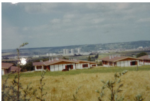
La construction du centre de Buchelay.
