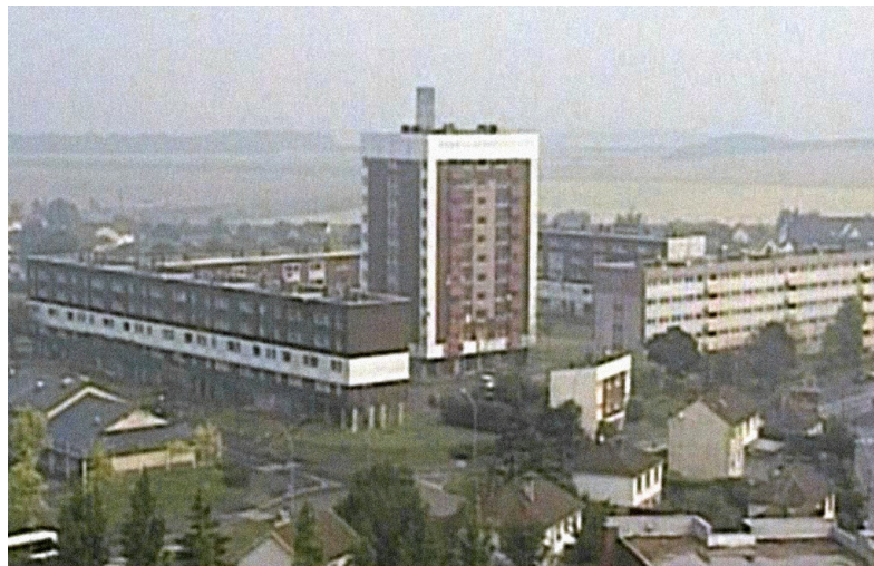
Vue lointaine des bâtiments bleus, rue Fafet. 417
